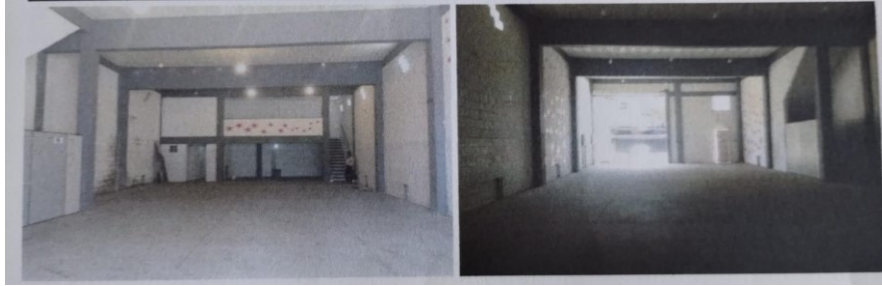
ANTES DA REFORMA - CENTRO DE TREINAMENTO - ANDAR TÉRREO
