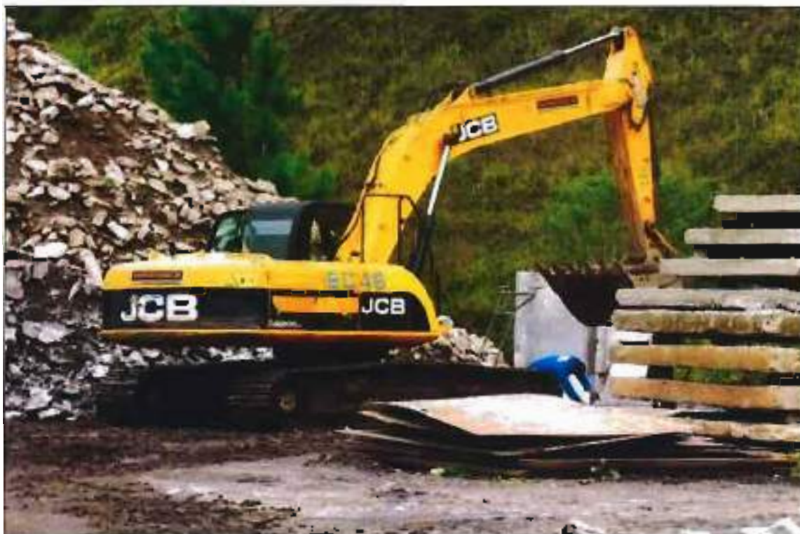
ITEM 2.085 – VISTA DA ESCAVADEIRA HIDRÁULICA MARCA: JCB MODELO: JS200LC CHASSI/SÉRIE: 9B9JS20D1633006 PLACA: Sem placa
