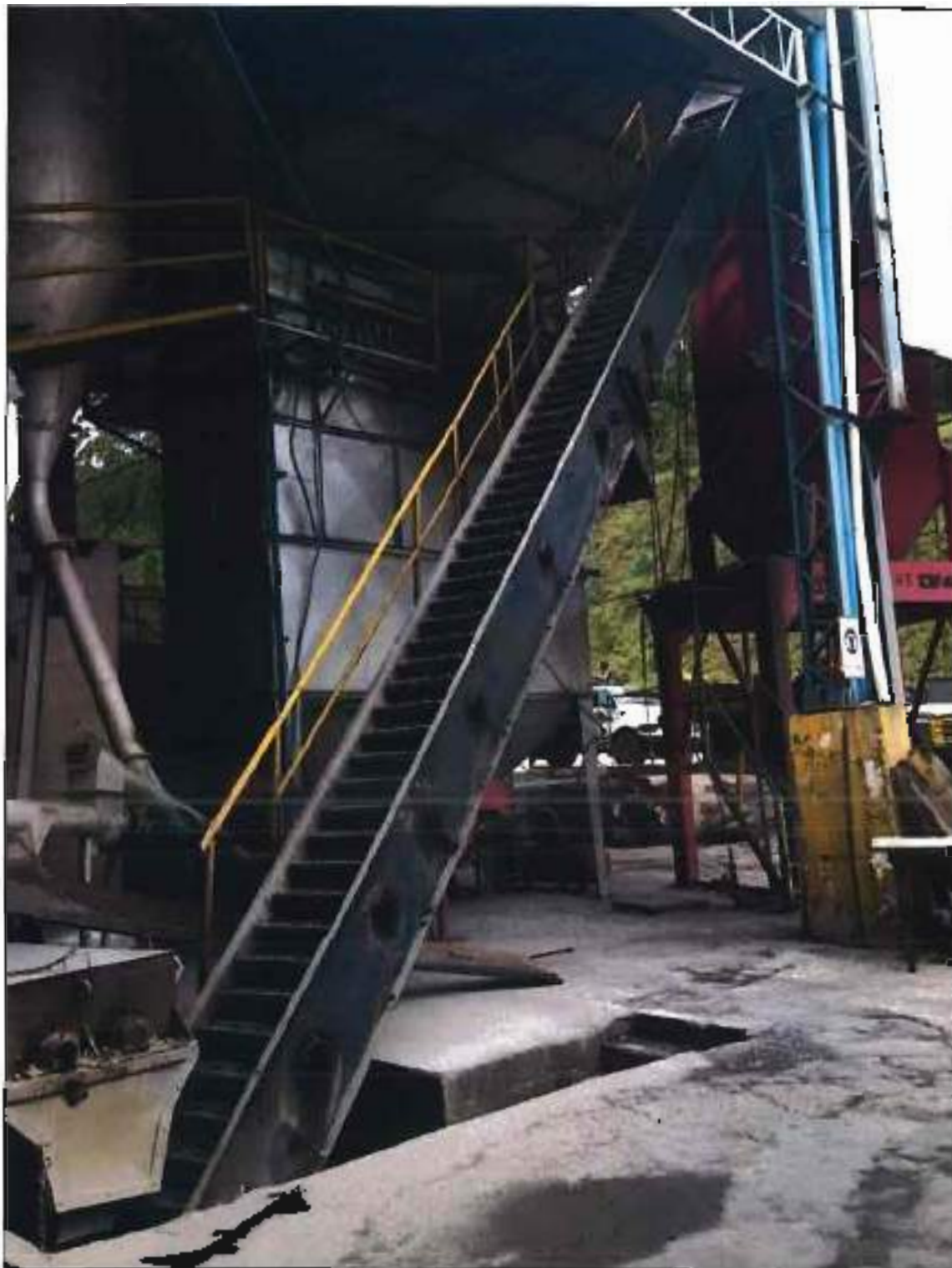
ITEM 1.002 - VISTA DA CORREIA TRANSPORTADORA INCLINADA DA LINHA USINA DE ASFALTO
