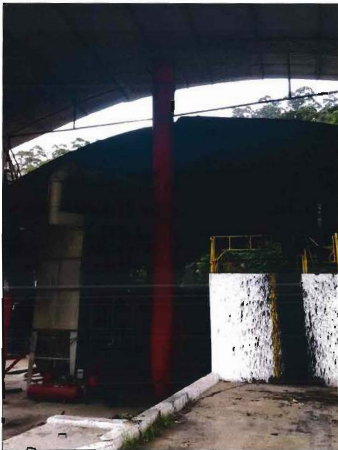
ITEM L,002 - VISTA DA CHAMINE DA LINHA USINA DE ASFALTO
