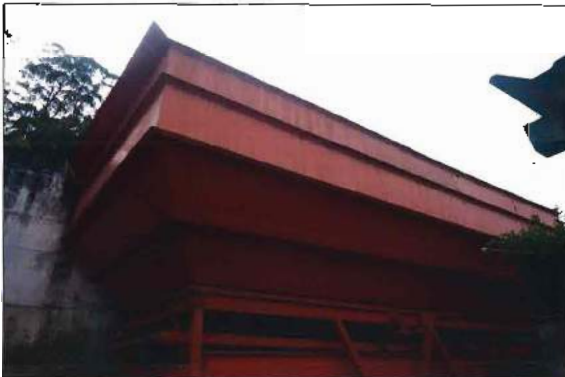
ITEM 1,001 – VISTA DO SILO COM 4 COMPARTIMENTOS DA LINHA CENTRAL DE CONCRETO
