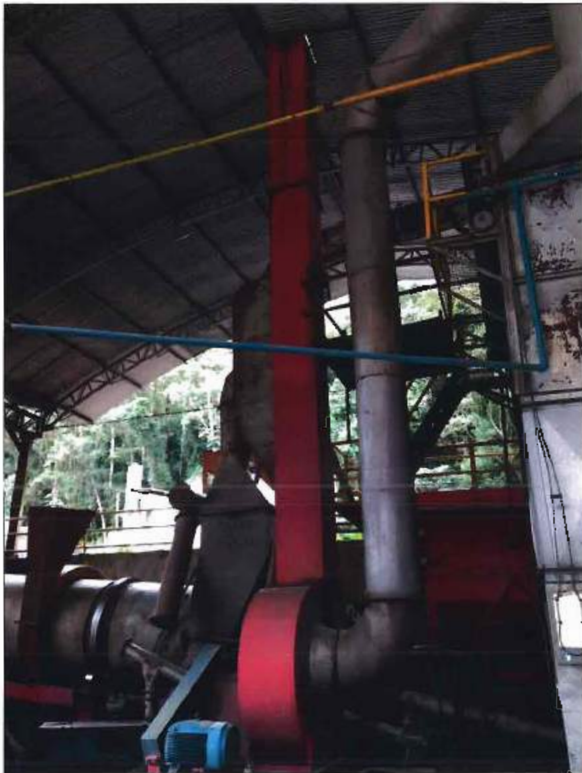
ITEM 1,003 - VISTA DA CHAMINE DA LINHA USINA DE ASFALTO
