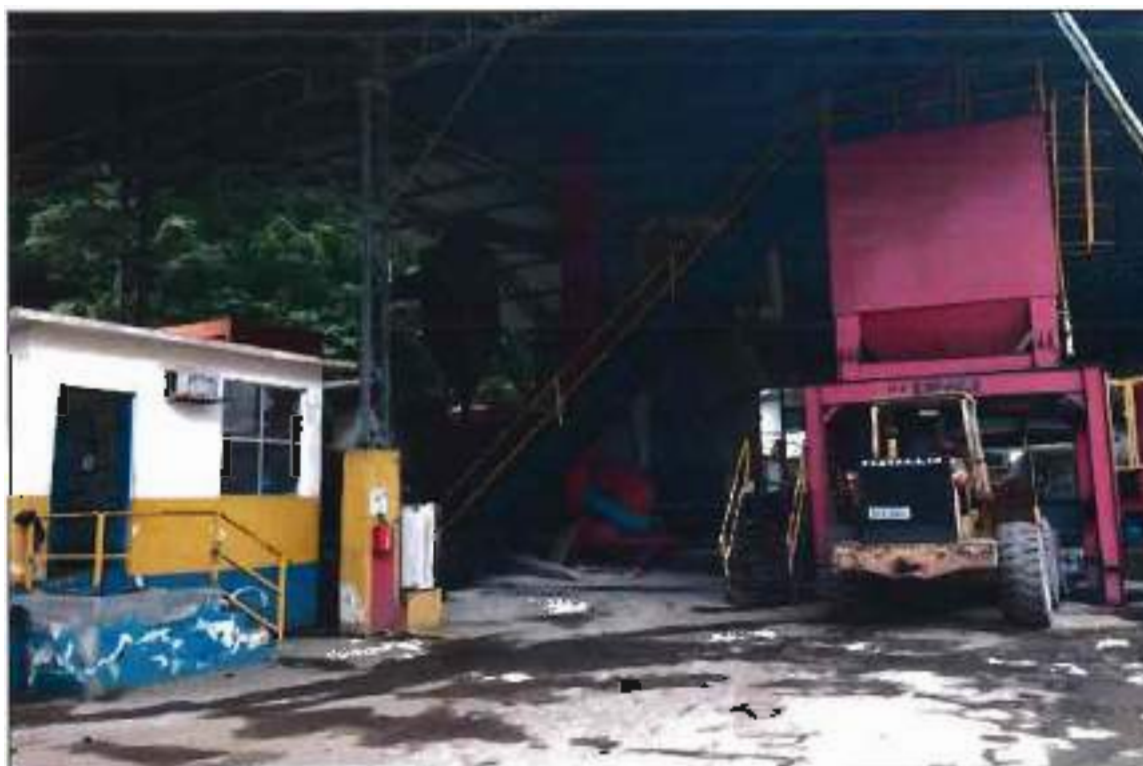
ITEM 1,003 - VISTA DA LINHA USINA DE ASFALTO
