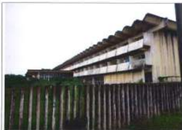
Vista geral – Construção Existente
