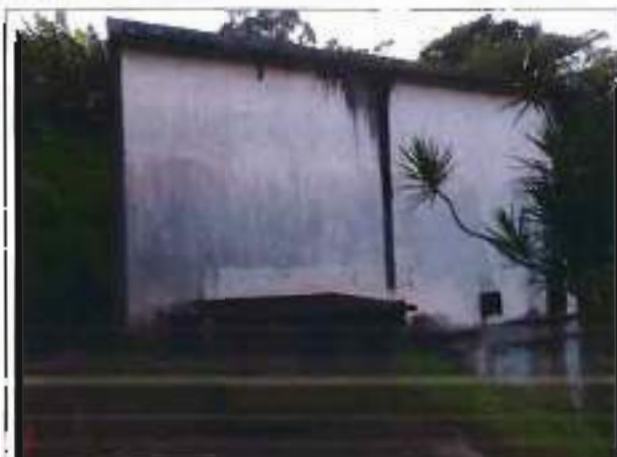
Cabine de força
