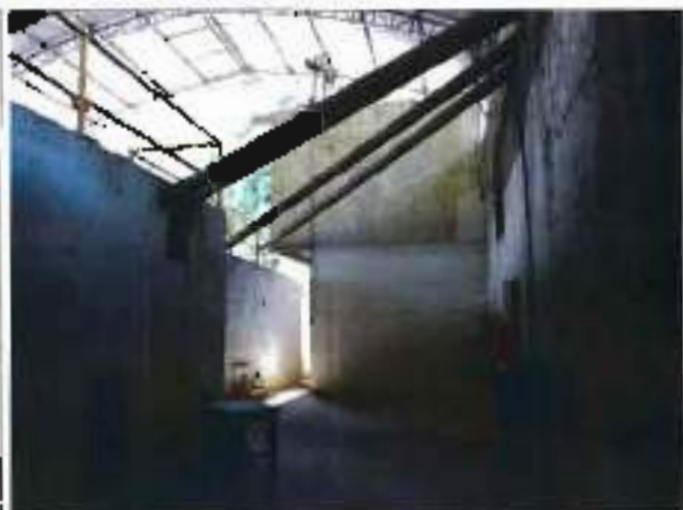
Usina e galpões
