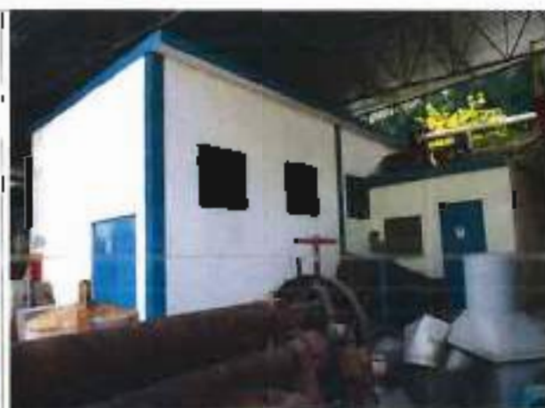
Cabine de força
