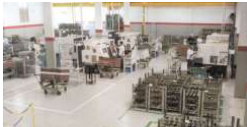
Figura 3 Edifício Usinagem e Ferramentaria
